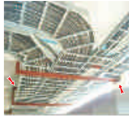
L-T Cable Laying
